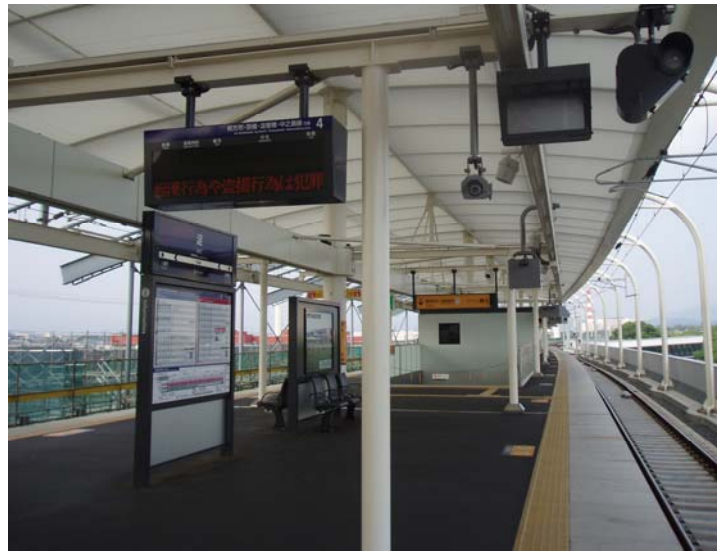
プラットフォームホーム(供用中下り高)
