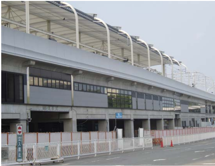
駅部高架橋(供用中下り高架)
