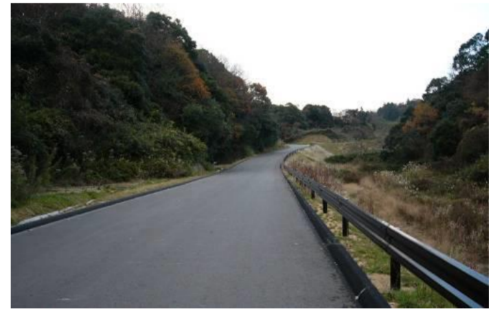
自然公園内園路整備
